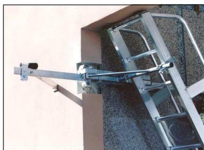
**La guida della scala scorrevole viene realizzata in modo da permettere al carrello la massima possibilità di scorrimento. In questo modo si può ottimizzare la raggiungibilità dei loculi.**
